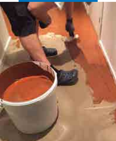
Mapecolor PU 462 påføres i en jævn tykkelse med en rive eller tandspartel
