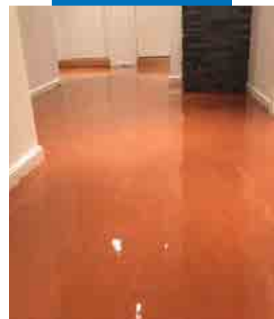
Gulve lagt med Mapefloor PU 462
